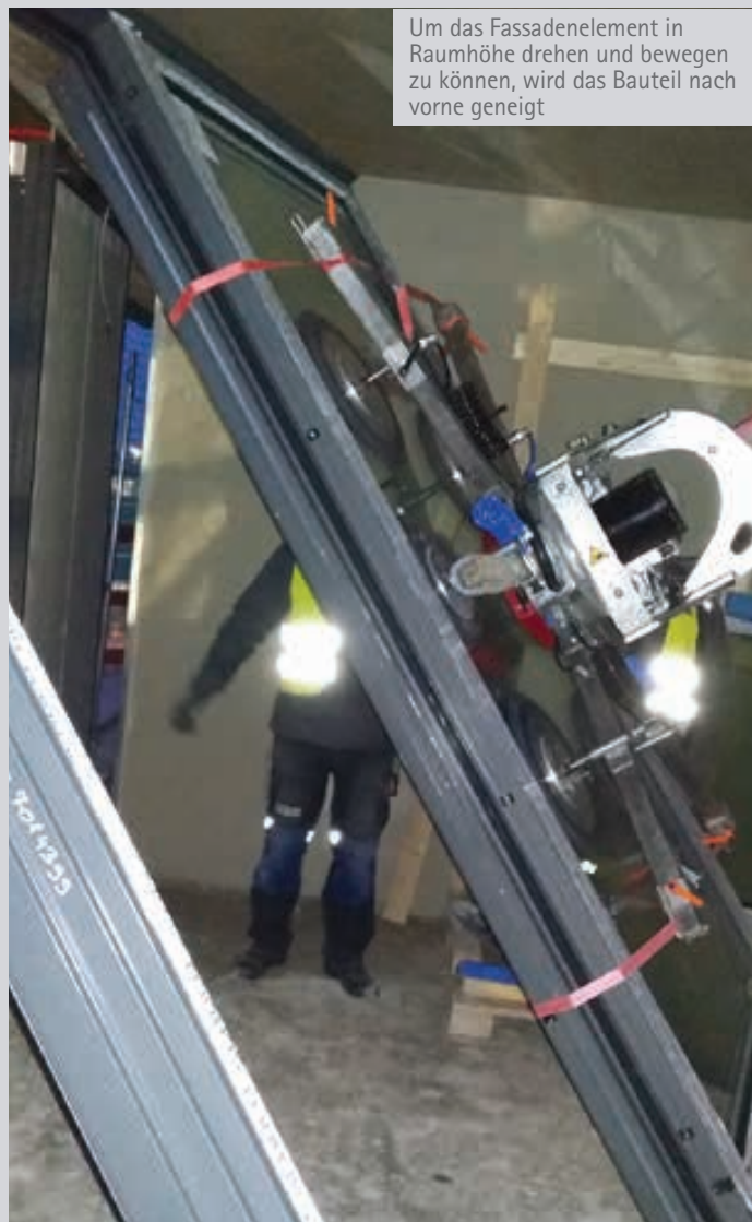
Der Glassworker nimmt das Element auf und bringt es an den Einbauort
