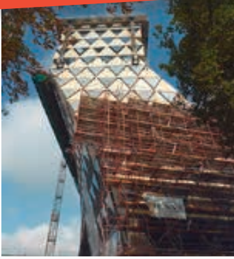
Erst Gerüst, dann Bühne: acht Maxi-Climber MC 650 Zweimaster von Böcker am Hafenhuis Antwerpen
