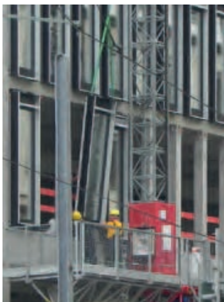
Einfacher Einbau der Fensterelemente dank Alimak (v.l. n.r.): einschweben, einpassen, kurze Fahrt nach oben und Endmontage
