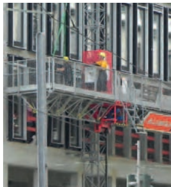
Einfacher Einbau der Fensterelemente dank Alimak (v.l. n.r.): einschweben, einpassen, kurze Fahrt nach oben und Endmontage
