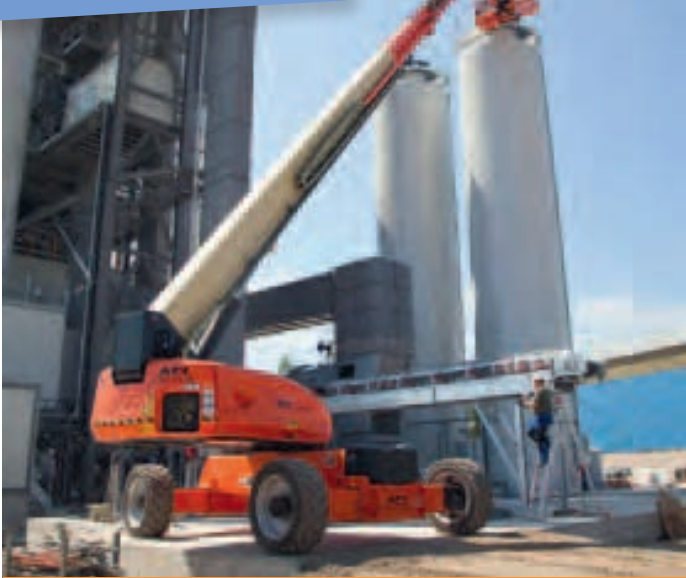
» Für den Bau einer Asphaltmischanlage in Nord-Niedersachsen kam eine JLG 1350SJ zum Einsatz. Die Maschine aus dem Mietpark von AFI Arbeitsbühnenvermietung konnte hier ihre hohe Reichweite von 24,38 Meter ausspielen, da der Bewegungsspielraum auf dem Gelände eingeschränkt war.
