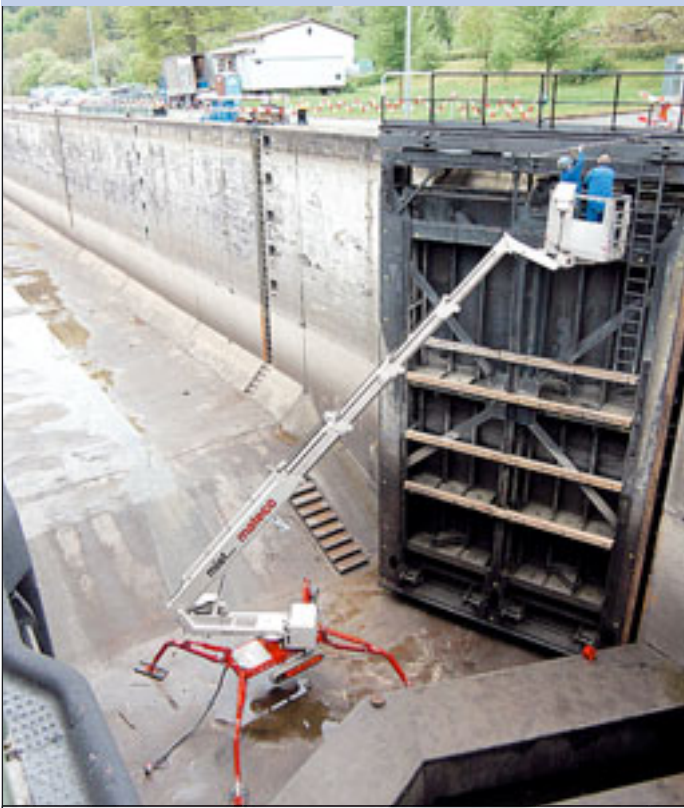
Spezielle Arbeitsbhünneneinsätze wie zum Beispiel in einer Schleuse...
