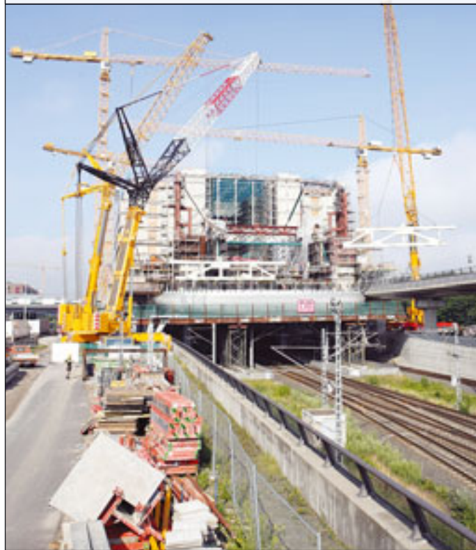
Zwei Terex AC 700 und ein Terex AC 500-2 bei der Montage eines Fachwerkträgers am Airrail Center Frankfurt
