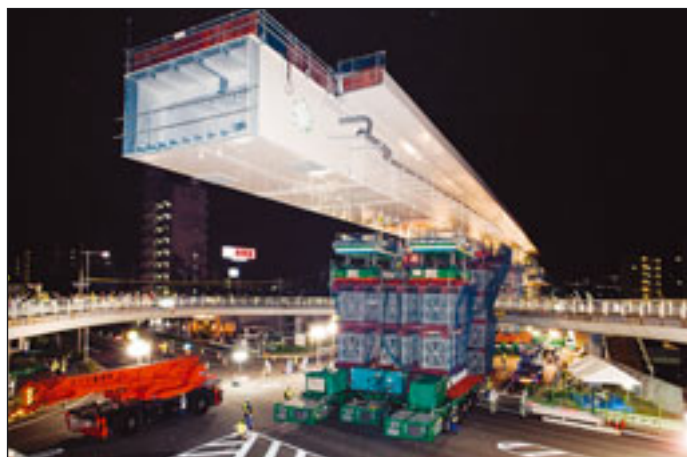
Ein 545 Tonnen schweres Bauteil schultert dieser Selbstfahrer Typ PST von Goldhofer
