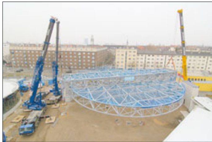
Drei Grove-AT-Krane positionieren in einem beengten Wohngebiet eine 160 Tonnen schwere Dachkonstruktion auf einer Tankstelle
