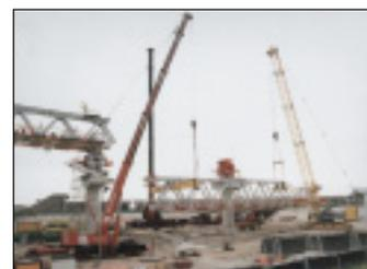
Beim Bau der neuen Bahnanbindung der niederländische Stadt Utrecht an den Flughafen Schiphol kamen zwei Demag AC 650 Teleskopkrane und ein Demag CC 2600 Raupenkrane von Mammoet zum Einsatz.
