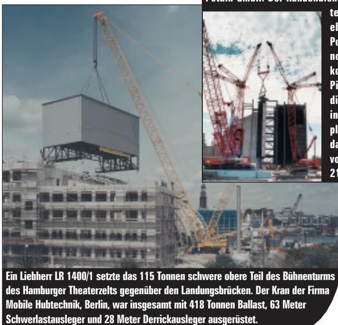
Ein Liebherr LR 1400/1 setzte das 115 Tonnen schwere obere Teil des Bühnenturms des Hamburger Theaterzelts gegenüber den Landungsbrücken. Der Kran der Firma Mobile Hubtechnik, Berlin, war insgesamt mit 418 Tonnen Ballast, 63 Meter Schwerlastausleger und 28 Meter Derricksausleger ausgerüstet.
