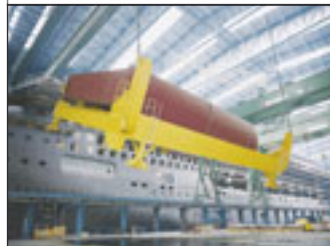
Wendemanöver: Die „upside down“ gefertigten Schiffssegmente werden gedreht
