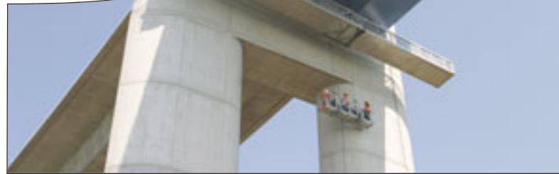
Inspektion der Strelasundbrücke von einem Cramer-Brückeninspektionsgerät aus. Mittels Seilbefahrung können auch die Pfeiler in Augenschein genommen werden.
