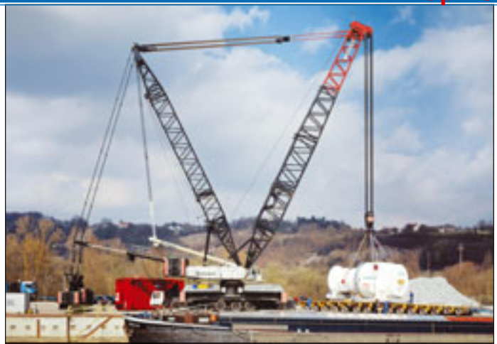
Zum Umschlag eines 380-Tonnen-Generators wird ein Liebherr-Gittermastkran LG 1750 mit 35 Meter langem Hauptmast und Derrickauleger im Donauhafen in Kelheim eingesetzt. Da die Krane der beauftragten Firma Felbermayr anderweitig im Einsatz waren, wurde der LG 1750 von Grohmann für den Job in Bayern angeheuert.
