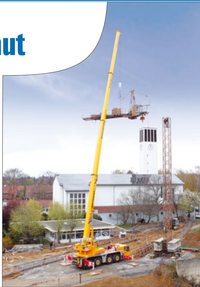
Wiesbauers AC 100/4 von Terex Demag im Einsatz
