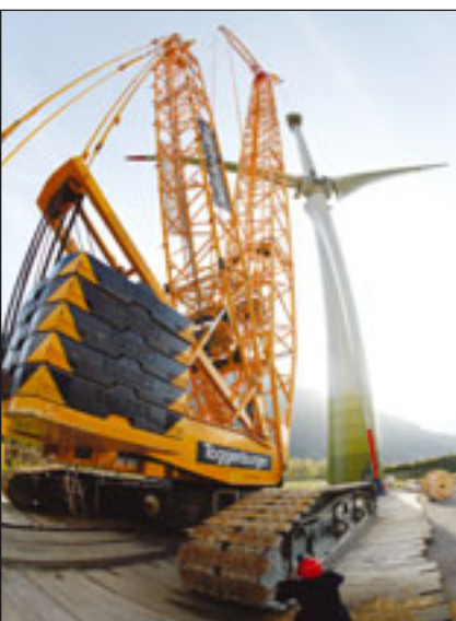
Neue Perspektive: Bei Martigny im Kanton Wallis hat Toggenburger die bisher größte Windkraftanlage der Schweiz, eine Enercon E82, mit einer Nabenhöhe von 98 Meter montiert. Ein Fall für den Terex Demag Raupenkran CC2500-1, ausgerüstet mit einem Ausleger 72 + 42 Meter SWSL.
