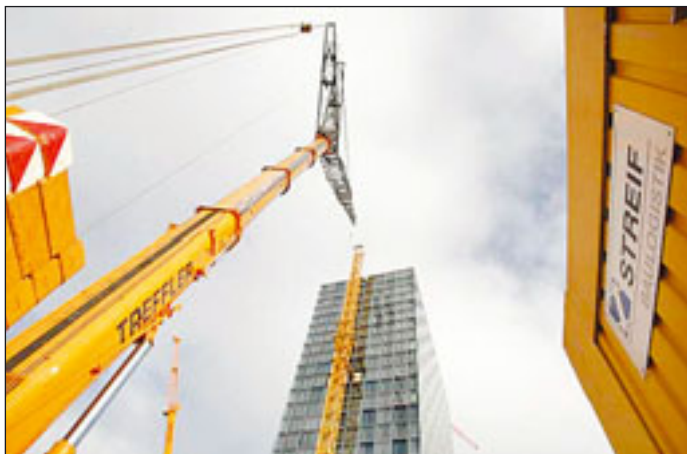
Abbau eines Turmdrehkrans beim Süddeutschen Verlag, München
