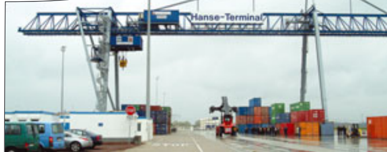
Ein Containerkran mit 41 Tonnen und 18/50/25 Meter sowie einer Hubhöhe von 15,4 Meter, im neuen Hansehafen Magdeburg
