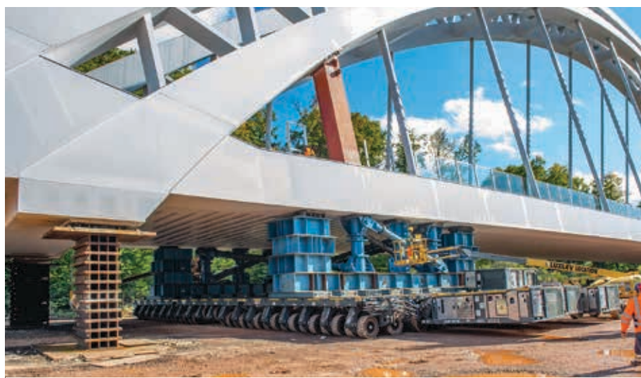
Sarens mit Cometto in Luxemburg: Erst per Hydraulik hochgepresst, dann über Selbstfahrer verschoben
