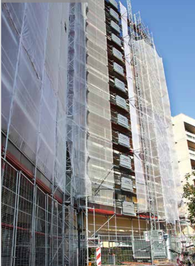
Der Zahnstangenaufzug Super-Lift MX 1024 von Böcker im Einsatz bei Sanierungsarbeiten am Wohnpark Gronau
