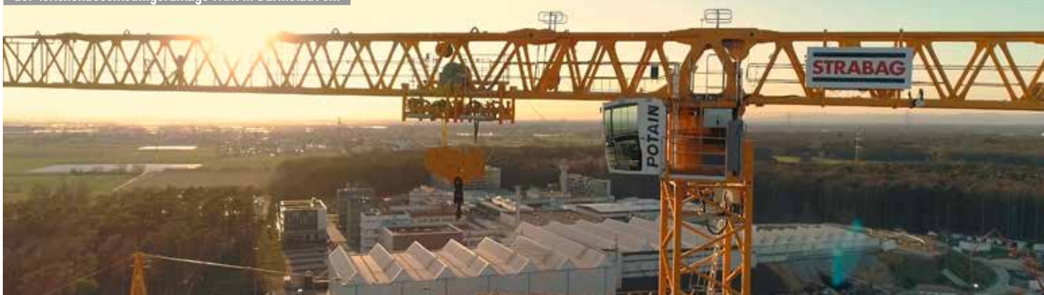
Strabag setzt den größten Potain-Turmdreher MDT 809 für den Bau der Teilchenbeschleunigeranlage FAIR in Darmstadt ein
