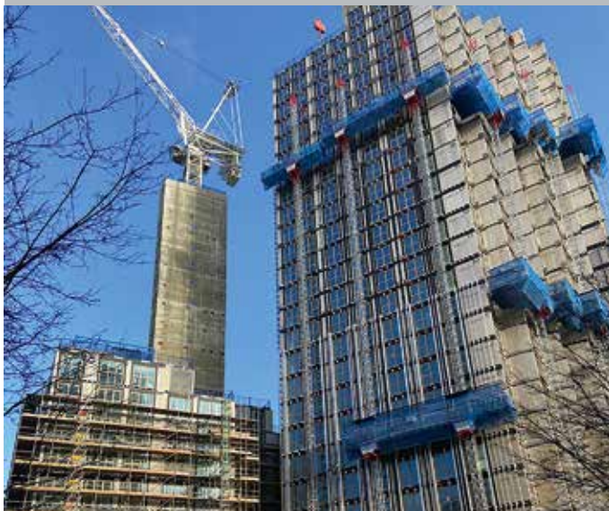
Arbeitsplattformen von Alba schmiegen sich der Gebäudeform des Londoner „Lewisham Exchange“ an
