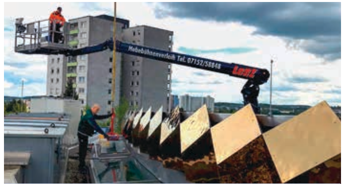
→ Bei einem Einsatz am SI Centrum in Stuttgart benötigten die Fensterbauer zur Verglasung eine 46-Meter-LKW-Arbeitsbühne und einen Raupenkran von Jekko, der es auf eine Hakenhöhe von 30,50 Meter schafft mit Glassauger. Das Equipment stammt vom Rutesheimer Vermieter Lanz.
