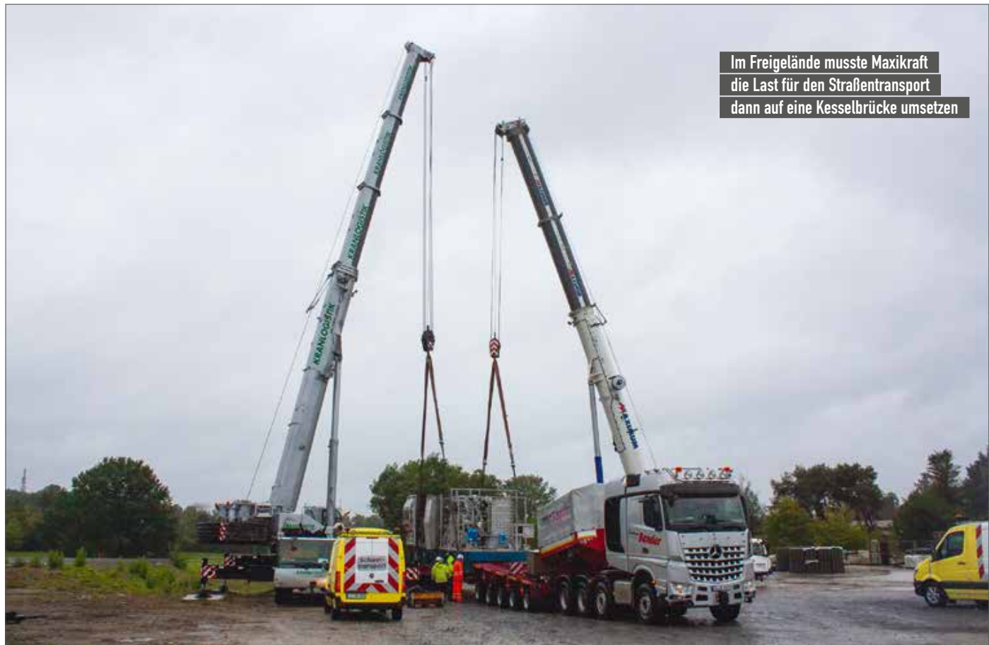
Platz gab es kaum, aber es reichte für Maxikraft, um den Kessel herauszuheben und auf den Transporter zu stellen
