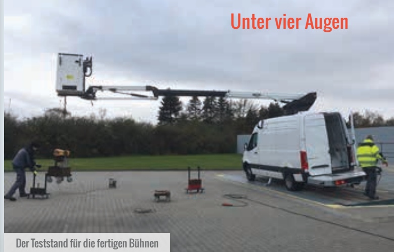
Hier erfolgt der Innenausbau
