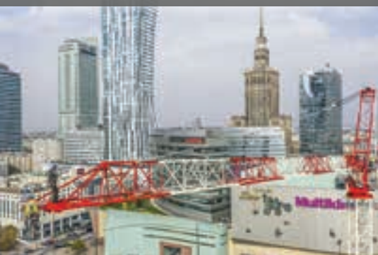
15 Terex-Krane sind beim Bau des Varso Tower im Einsatz
