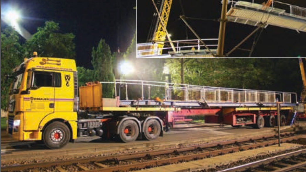
5 Tieflader fahren die Brückenteile ab
