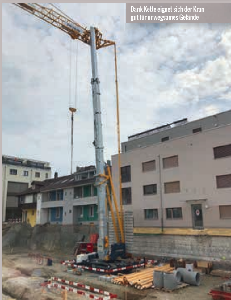
Die Montage gestaltet sich unkompliziert
