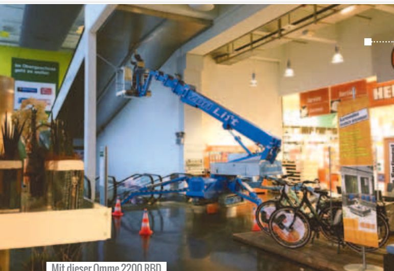
Mit dieser Omme 2200 RBD ging Zürlift in das Einkaufszentrum Grütze in Winterthur
