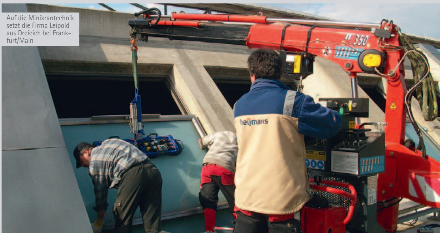
Per Container liefert Scholpp seine Unic-Minikrane an
