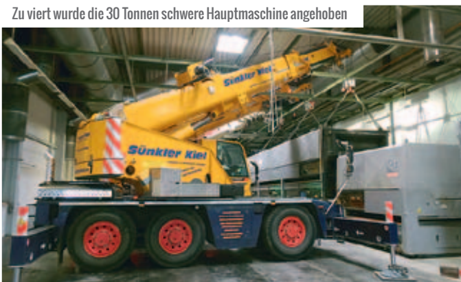
Zu viert wurde die 30 Tonnen schwere Hauptmaschine angehoben
