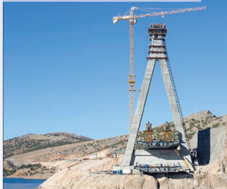
Zwei Potain-Turmdrehkrane des Typs MC 235 B des türkischen Vertragshändlers Tekno Vinç sind am Bau der Nissibi-Brücke beteiligt
