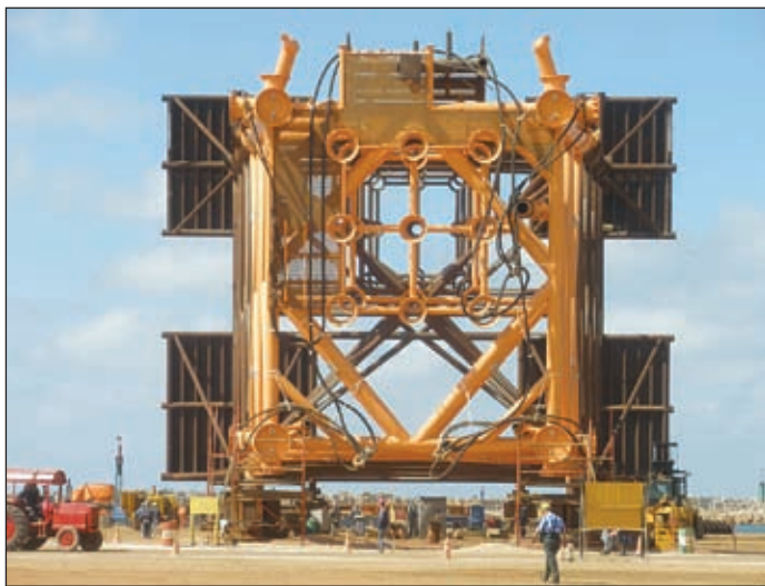
SCS setzte in Alexandria auf sein synchrones Stufenhubsystem
