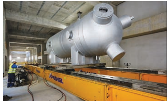
...bevor sie dann auf einer Vershubbahn weiter transportiert wurden
