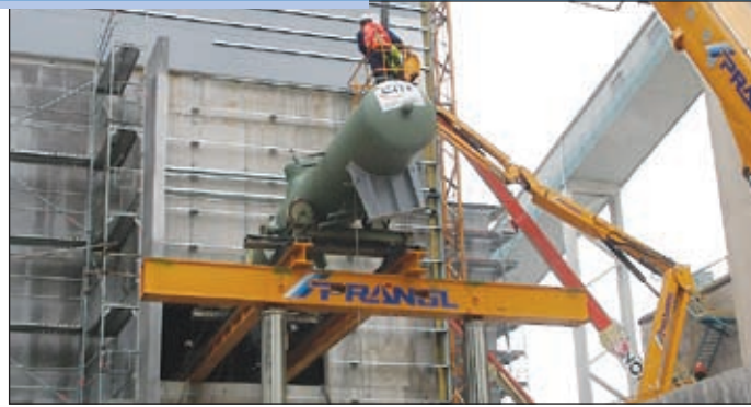
Am Kraftwerk Sostanj musste Prangl zwei der 14 Behälter von außen per Kran einbringen...
