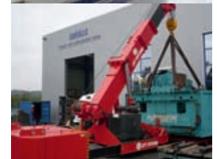
Mobilkran Kapazität 68 to. und Lift System Model 48 A bei einer Pressenmontage
