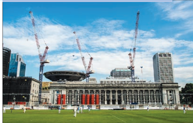
Drei 24-Tonnen-Wippkrane von Linden Comansa aus der LCL 500-Serie bauen an der National Art Gallery in Singapur.
