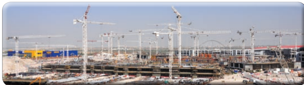
Mit 28 Sicherheitssystemen für Turmkrane ist dies laut AGS die weltweit größte Baustelle in Sachen Antikollisionssysteme: Sie liegt auf der Insel Yas im Persischen Golf, wo eine Shopping Mall errichtet wird
