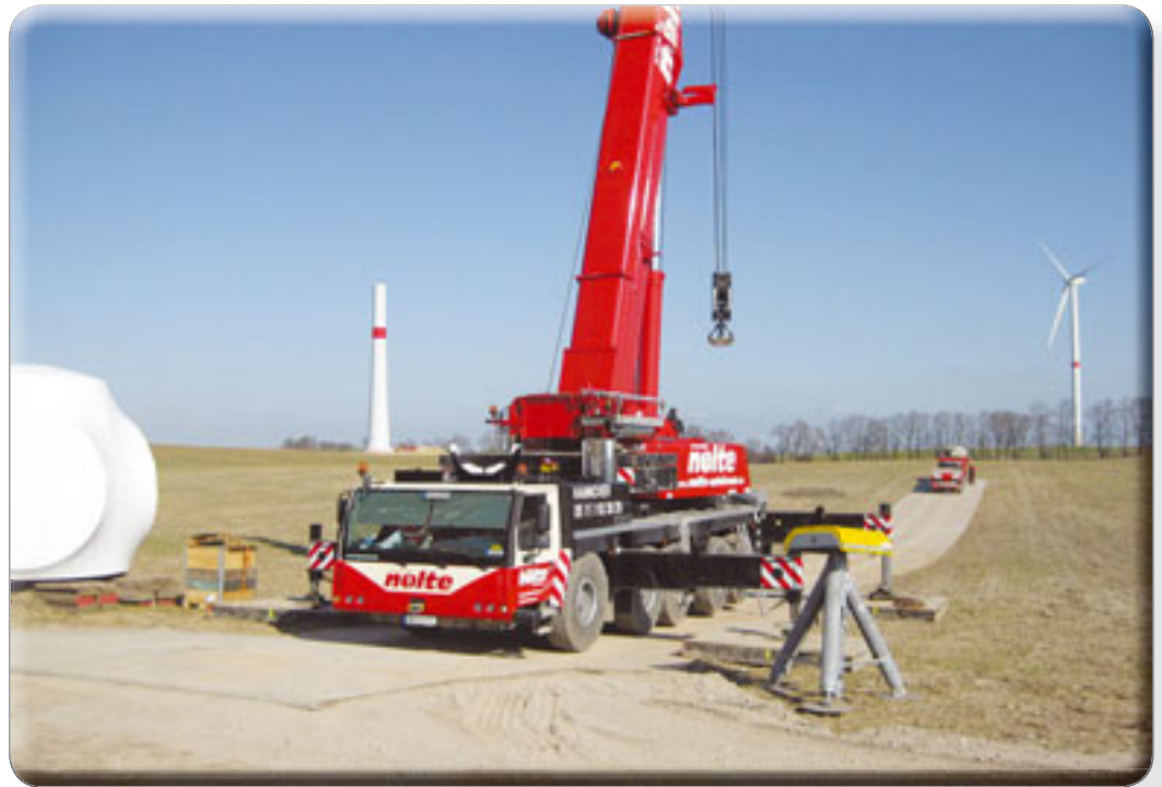
Sicherer Untergrund für Montage- und Hilfskran – hier im Windpark Pinnow
