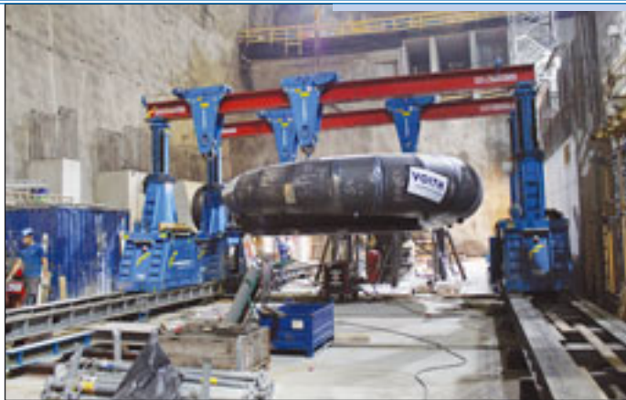
Für die letzten Meter Transportweg der 56 Tonnen schweren Spirale nutzte Felbermayr ein Hubgerüst
