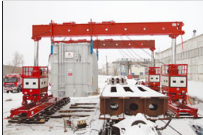
Greiners Hubsystem ist nicht für Hublasten bis 1.100 Tonnen ausgelegt, sondern auch auf Einsätze im Permafrost bis -40 Grad
