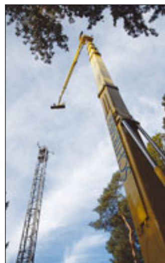
Vom Korb aus werden die Antennen eingedreht
