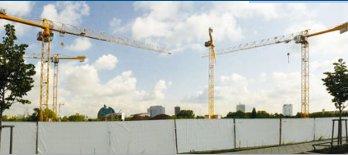
Mit vier neuen Potain MDT 128 errichtet die Sahle-Gruppe in Frankfurt die „Helenenhöfe“
