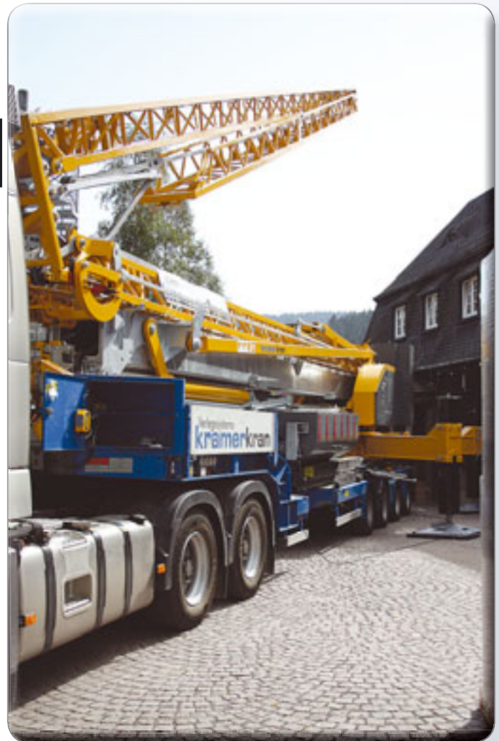
Auf engstem Raum kann der Kran direkt an die Störkante gefahren und aufgestellt werden, wie bei diesem Einsatz in Hinterzarten im Schwarzwald
