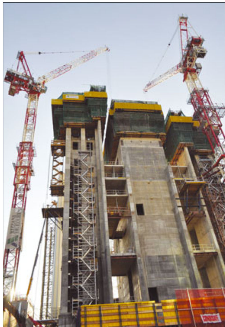
Eng geht es auf der Baustelle in Turin zu, so dass auf Wipprkrane von Terex zurückgegriffen wurde
