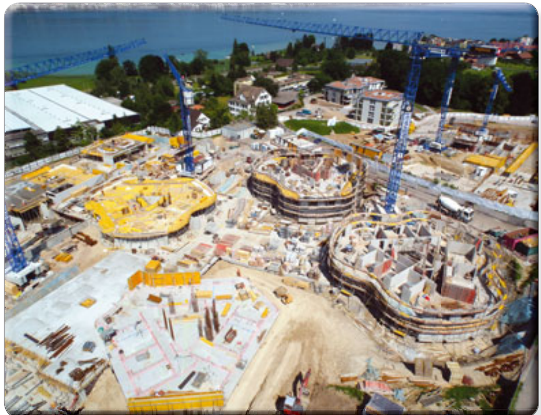
Gleich fünf Raimondi-Krane setzt die Schweizer Interkran AG auf dieser Baustelle ein
