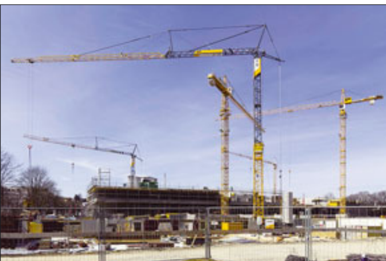
Die neuen 81K können auf dieser Baustelle in Biberach/Riss ihre Vorteile voll ausspielen
