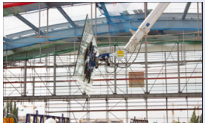
Beim Umbau des Berliner Ostkreuz werden die Scheiben von innen eingesetzt
