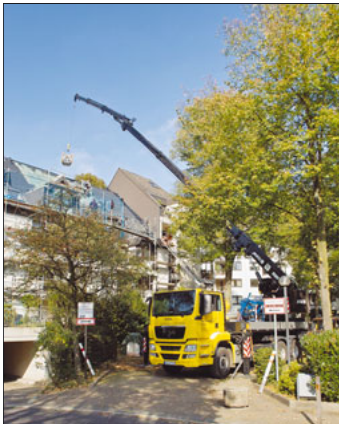
MKG-Kran im Einsatz
