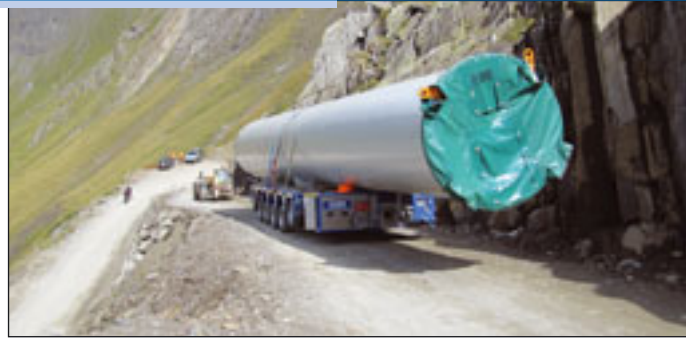
Die Turmsegmente „wandern“ über den Nufenenpass
