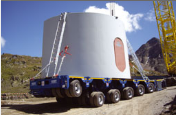
40 Tonnen Betonturm-Halbschale mit gelifteter erster Achslinie
