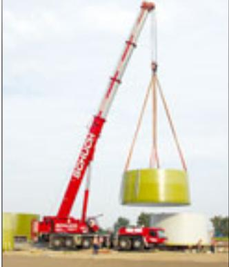
Tonnen bei einer Ausladung von 11,20 Meter. Kranbediener Winnie Backer ist voll des Lobes über sein neues Arbeitsgerät: „Dieser Kran war perfekt geeignet für die ersten Segmente dieser Windkraftanlage. Toll ist auch, dass der Kran sein eigenes Gegengewicht montiert, sodass ein Hilfskran entfällt – was das Ganze beschleunigt und günstiger macht für unseren Kunden. Außerdem konnten wir den Kran
