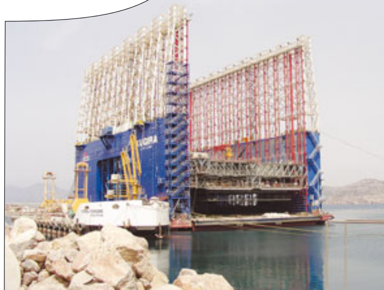
Der Kugira, der weltgrößte Betonblock-Builder, mit Enerpac-Hydrauliksystem
