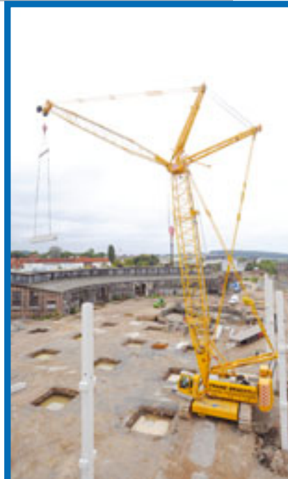
Bei diesem Bauprojekt in Fulda wird der denkmalgeschützte Lokschruppen in ein Möbelhaus integriert. Zwei Sennebogen-Raupenkrane 4400 und 5500 von Franz Bracht sind im Einsatz.
