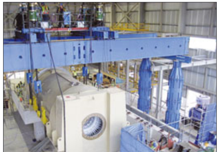
Felbermayr vollbrachte die Fundamentstellung eines Generators per Litzenheber
