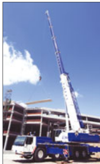
Liebherr LTM 1220-5.2 bei der Kranarbeit
