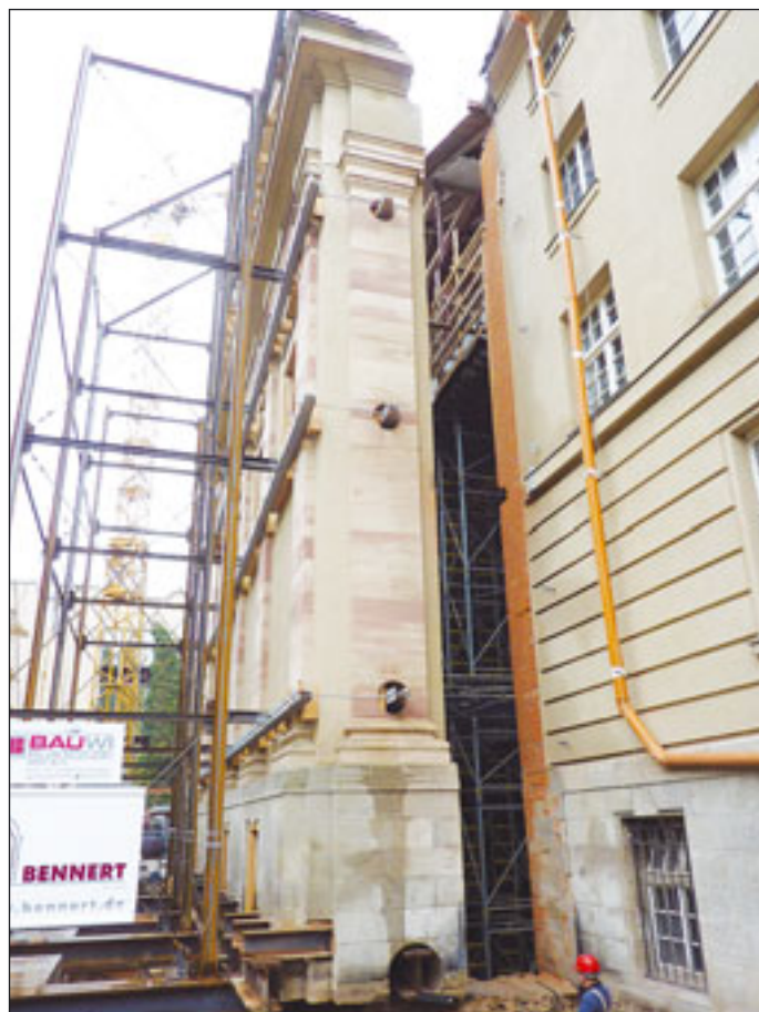
Konecranes lässt die Theaterwand mittels Fluidsystem „wegschweben“
