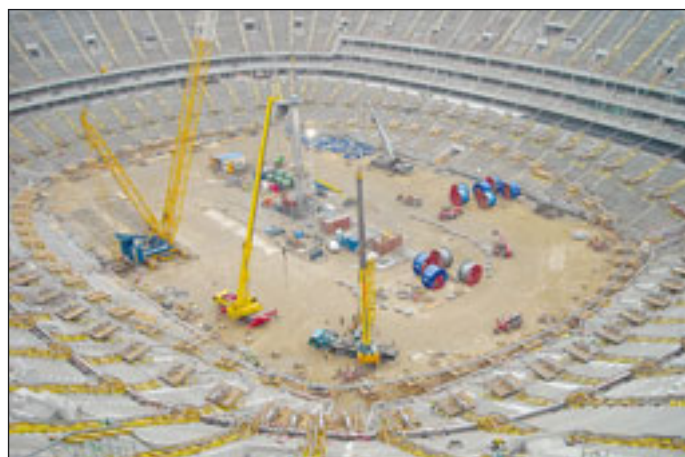
Eisiger Einsatz für VSL in Warschau: Das ausgelegt Seiltragwerkdach mit Nadel vor dem Anheben
