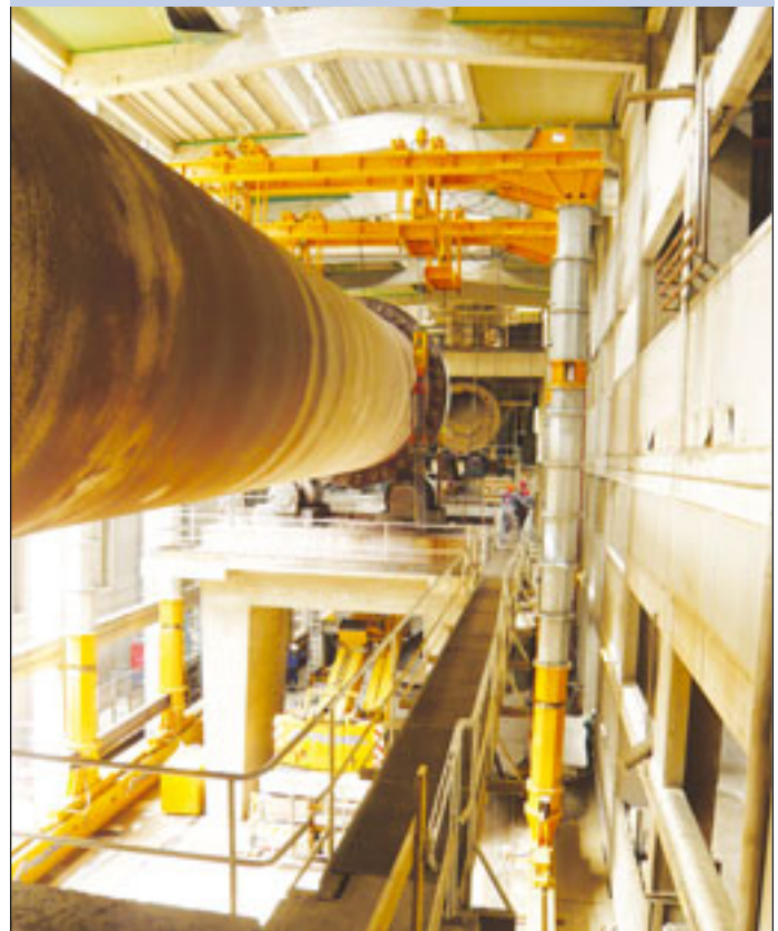
Enge, soweit das Auge reicht: Prangl demontiert einen Drehrohrföfen mit alternativer Hebetchnik
