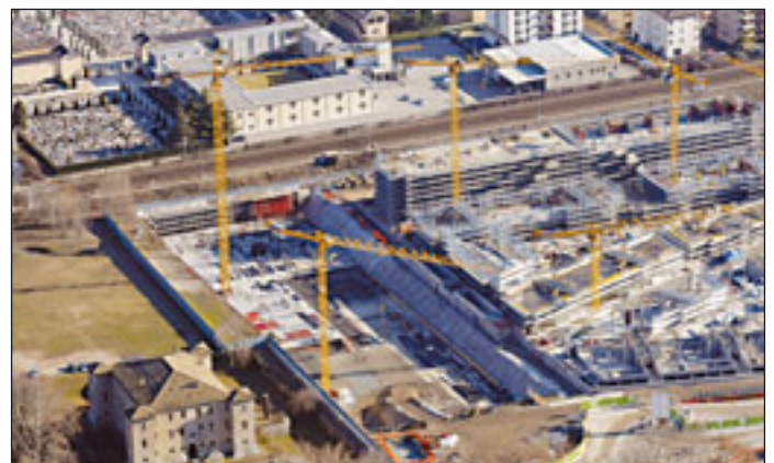
Knapp ein Dutzend Potain-Krane sind auf einer Großbaustelle im norditalienischen Trient im Einsatz, davon etliche Spitzenlose
