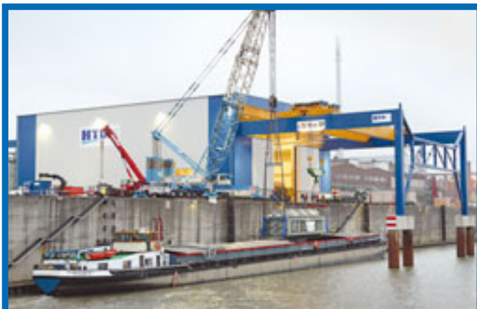
Die Feuertafe bestand die neue Schwergutanlage in Duisburg mit einem extrem schweren Trafo, der 450 Tonnen auf die Waage brachte. Per Tandemhub wurde er von dem 250-Tonnen-Hallenkran und einem schweren Gittermastkran in ein Binnenschiff verladen.
