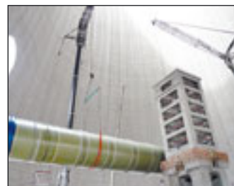
...und im Tandemhub angehoben...
