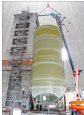
...wird das Rohr in die richtige Stellung gebracht...
