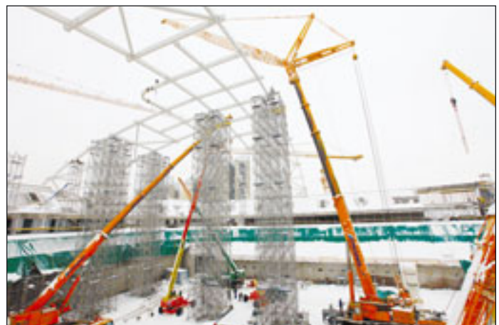
Auf der größten Baustelle Sloweniens, dem Sportpark Stožice, war die Firma Prangl mit bis zu sieben Mobilkranen vertreten. Zur Verhebung des Stahlgerüsts wie auch zur Verlegung der Dachelemente wurden ein 130-Tonnen-Teleskopkran sowie zwei 100-Tonner eingesetzt. Für die Dachkonstruktion der Sporthalle mussten drei Fachwerkskörper wie ein Bogen mit einer Spannweite von etwa 100 Meter montiert werden. Die beiden Seitenteile wurden von je einem 160 Tonnen und 200 Tonnen Mobilbaukran gehalten, während das Mittelsegment von einem 300-Tonner mit Wippausleger eingehoben wurde.
