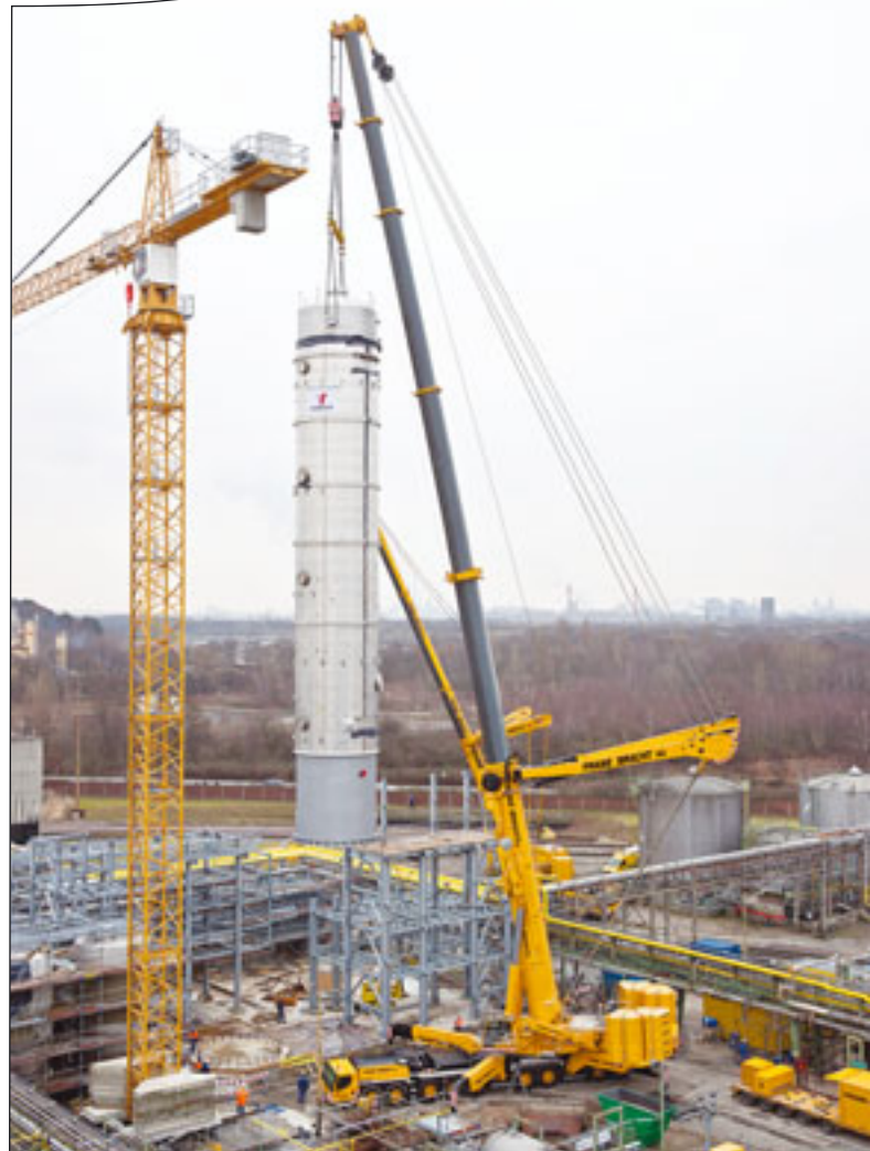
Der Liebherr LTM 11200-9.1 von Bracht war mit über 200 Tonnen Gegengewicht gerüstet
