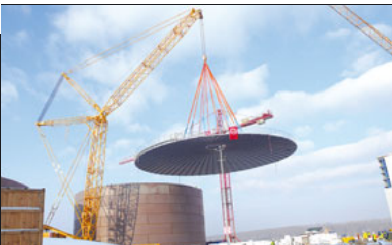
Dächer mit einem Eigengewicht von 95 Tonnen und einem Durchmesser von 35 Meter hingen am Haken des Terex-Demag CC 2800 von Prangl
