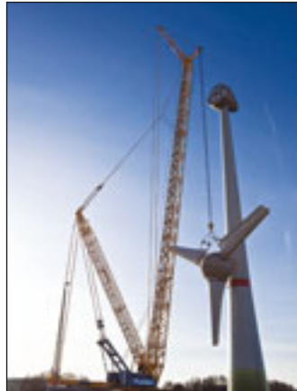
Nur im unteren Bereich wurde die Last mit einem zweiten Kran nachgeführt. Den Weg bis zum Maschinenhaus hob der CC 9800 die Last alleine
