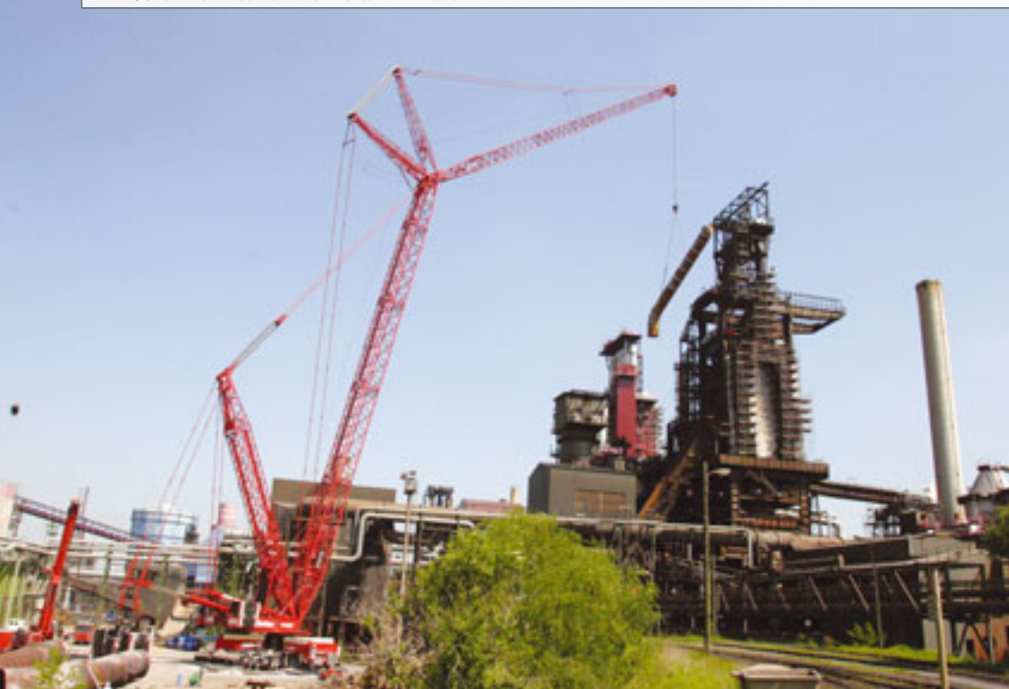
Ein Liebherr LG 1750 von H.J. Nolte im Einsatz
