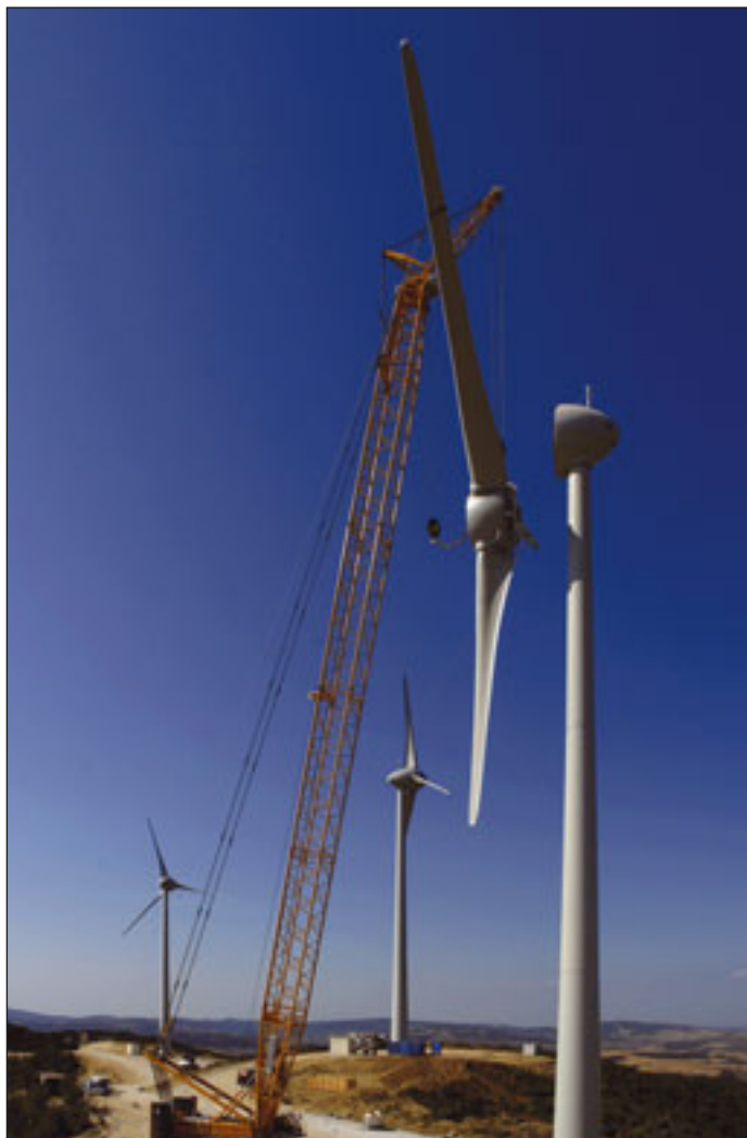
Liebherr's LR1280W mit automatischer Spurverstellung in einem Windpark in der Türkei
