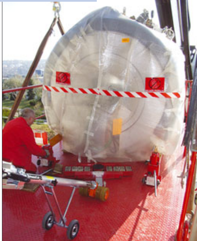
Ein 10 Tonnen schwerer Kernspintomograph wird für die Einbringung mittels Powercat vorbereitet
