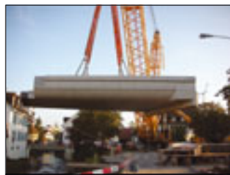
Prunkstück von Toggenburger ist der CC 2500-1, der hier die Reppischbrücke einhebt
