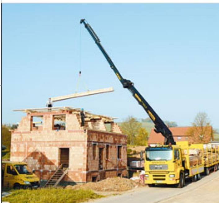
Die Anforderungen an einen Montagekran für Zimmerei- und Holzbaubetriebe sind rasch erklärt: große Armlängen, schnelle Bewegungsabläufe, Präzision, einfache und sichere Bedienbarkeit, solide Standsicherheit sowie ein wirtschaftlicher Betrieb. Der Palfinger PK 40001 EL Performance erfüllt all diese Ansprüche, so zumindest die Meinung des Zimmermei-
