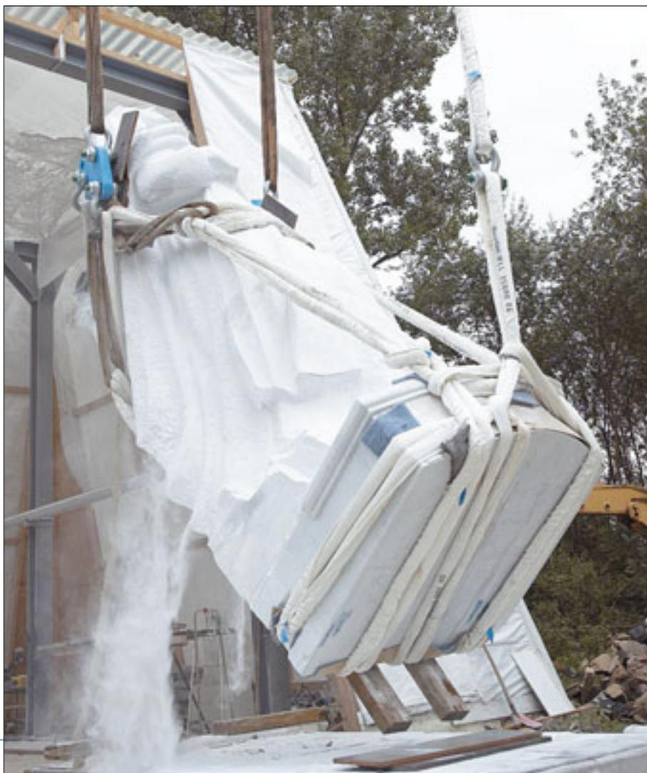
kern der Firma Span-Set wurde eine Spezialkonstruktion erarbeitet, die aus Rundschlingen-Sonderanfertigungen mit 25 Tonnen und 30 Tonnen Tragfähigkeit sowie Verbindungsblechen bestand. Um Beschädigungen zu vermeiden, entschied man sich für eine Hebekorblösung, mit der die Statue in der Luft gedreht werden konnte.
