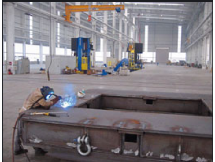
In der überwiegend noch leeren Halle läuft schon der Stahlbau
