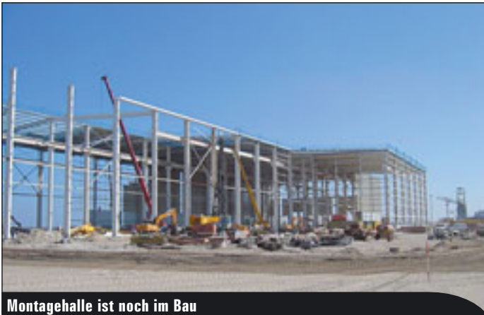
Montagehalle ist noch im Bau
