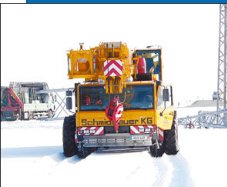
Spezielle „Moorreifen“ mussten auf dem Tadano-Faun ATF 80-4 von Schmidbauer montiert werden, um auf morastigem und verschneitem Untergrund Masten für eine Hochspannungsleitung zu installieren.
