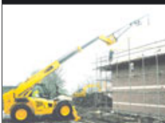
Gerade beim Hausbau sind diese Geräte nützliche Allrounder für viele Aufgaben, hier ein JCB 533
