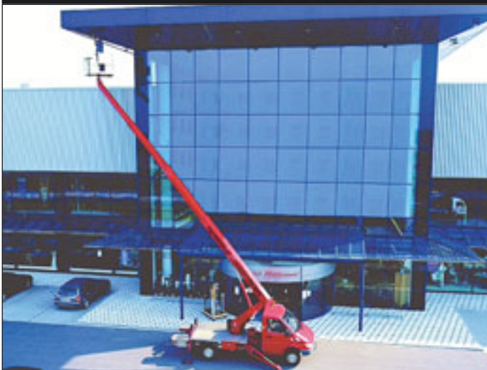
Fassadenarbeiten mit der Ruthmann TB 220
