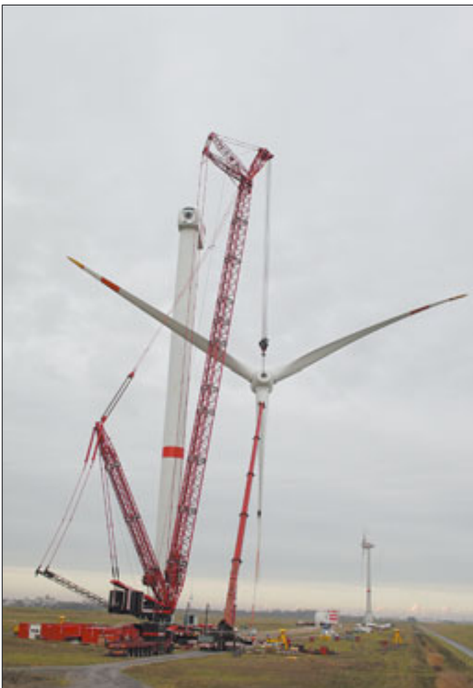
Einen der ersten Einsätze der neuen LR 11350 konnte man im Norden Deutschlands beobachten. Der Großbraupe in den Farben Mammoet hob einen Rotor ein, unterstützt von einem 7-Achser AT-Kran.
