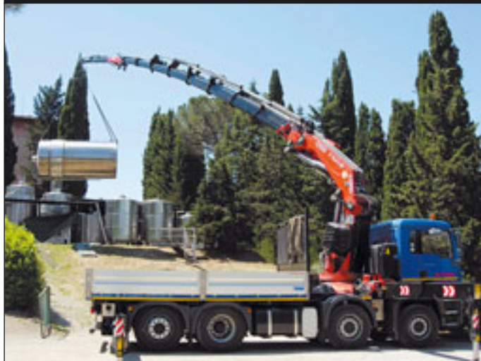
Der Fassi F1100XP im Einsatz
